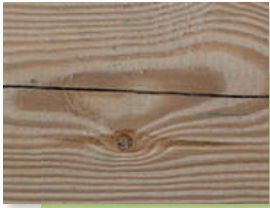
Spannungsrisse durch die Holztrocknung
