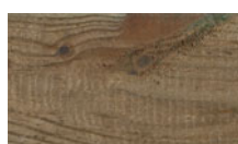
Rauhe Stellen auf der Holzoberfläche
