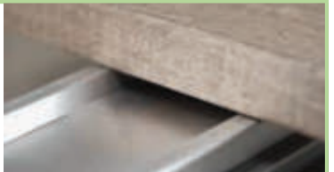
Alu Unterkonstruktionsschiene Relo K Empfehlung: Achsabstand 40-45 cm Auflagerabstand Achsmaß 55-60 cm
