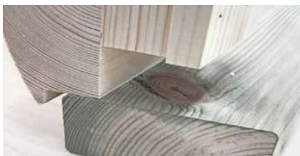
Wandelement auf imprägnierten Rahmen
