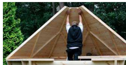
Vorgefertigte Dachelemente
