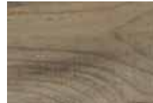
Umweltkeime, Stockflecken und leichter Schimmelbefall
