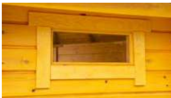
Fenster mit Sicherheitsglas | Außenansicht
