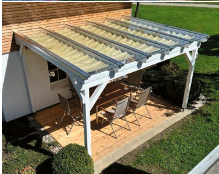
^ Pergolaüberdachung mit Terrassendielen aus Douglasie
